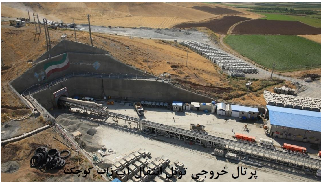
شکل (۴-۲۸) نمایی از پرتال خروجی تونل انتقال آب از رودخانه زاب کوچک به دریاچه ارومیه در زمان اجرای پروژه
